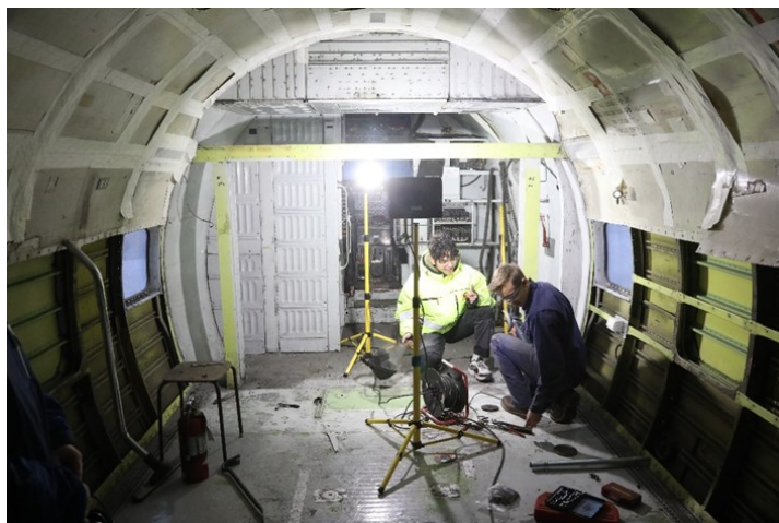
Fjerning av vegg i kabinen.
