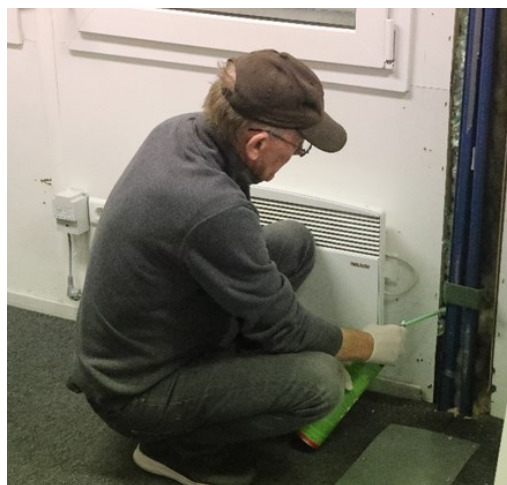
Siegfried tetter fugene mellom brakkene med bygningsskum.
