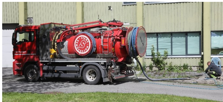
Arbeidet med å rense drencrørene rundt bygget er i gang.
