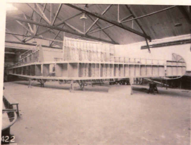
Struttura semiali in allestimento.
