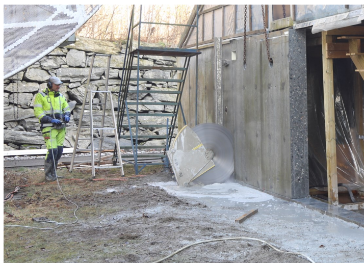
Betongen sages opp i mindre stykker
