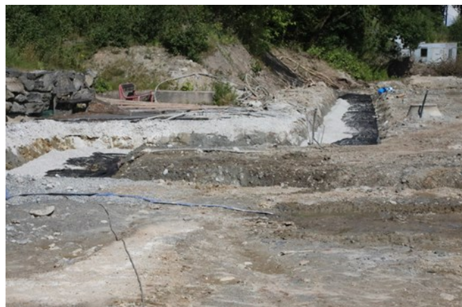
Utgraving for grunnmurer
