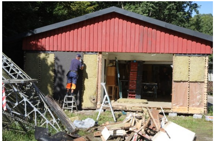
Da porten skulle settes inn i veggen på snekkerboden var det nødvendig å skifte deler av kledningen og legge ny isolasjon.
