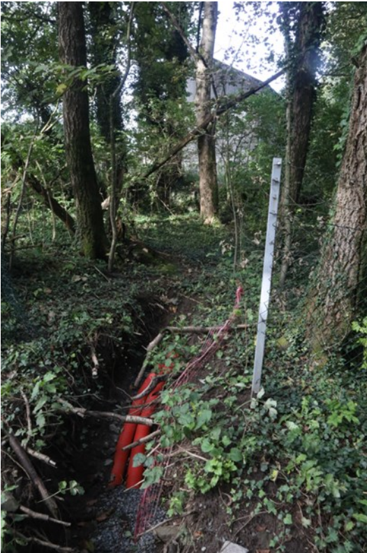
Trekkerøret som skal forlenges frem til trafokiosken som skimtes i bakgrunnen.
