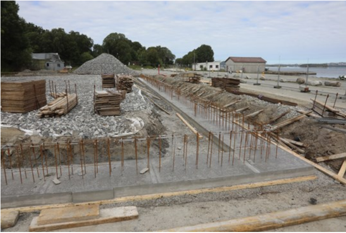
Etterfulgt av forskaling, arming og støping av fundamenter og grunnmur.
