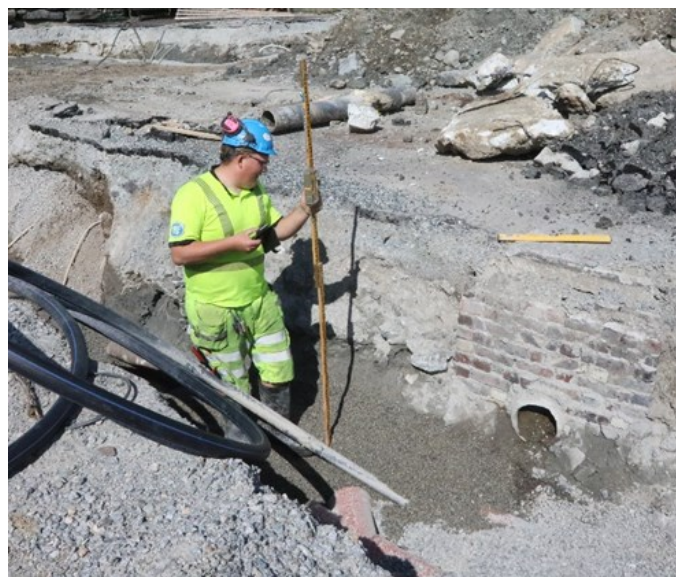
Fra legging av avløpsrør
