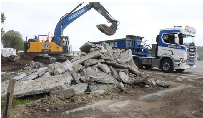
Gammel betong må fjernes og resirkuleres før en kan begynne byggearbeider.
