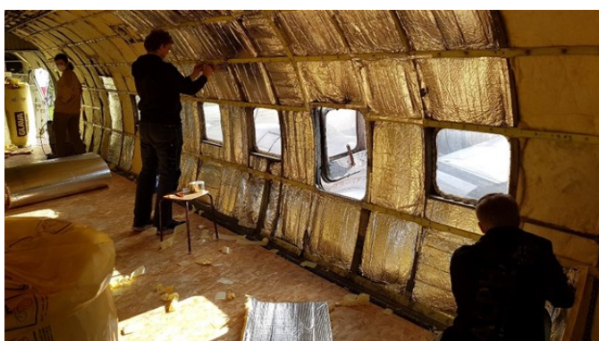
Innvendig isolering av cabinen
