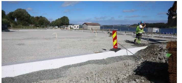
Så ble det lagt et lag pukk som underlag for isolasjon og gulvstøp
